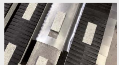
Nachträglicher Einbau der Emissionsklappen
