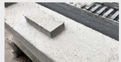
Halteklötzchen aus faserverstärkten Beton.
