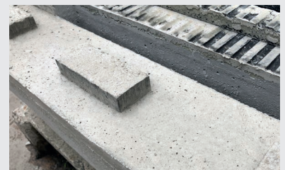
Megerősített betonból készült rögzítőblokkok.
