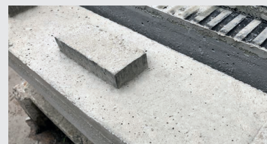
Zadrževalni bloki iz betona, ojačanega z vlakni.
