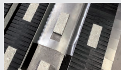
Nachträglicher Einbau der Emissionsklappen
